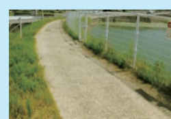
転落防止柵設置
