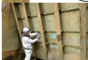
頭首工の扉体の診断状況
