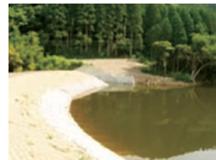
改修後のため池
