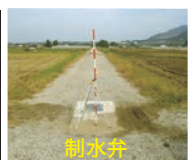
漏水時には、構造、制水弁の情報等を表示し応急対応が可能
