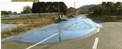
パイプライン（埋設管）の漏水状況
