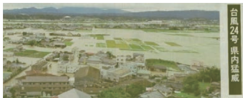
台風24号 (H30.9月) による湛水被害
